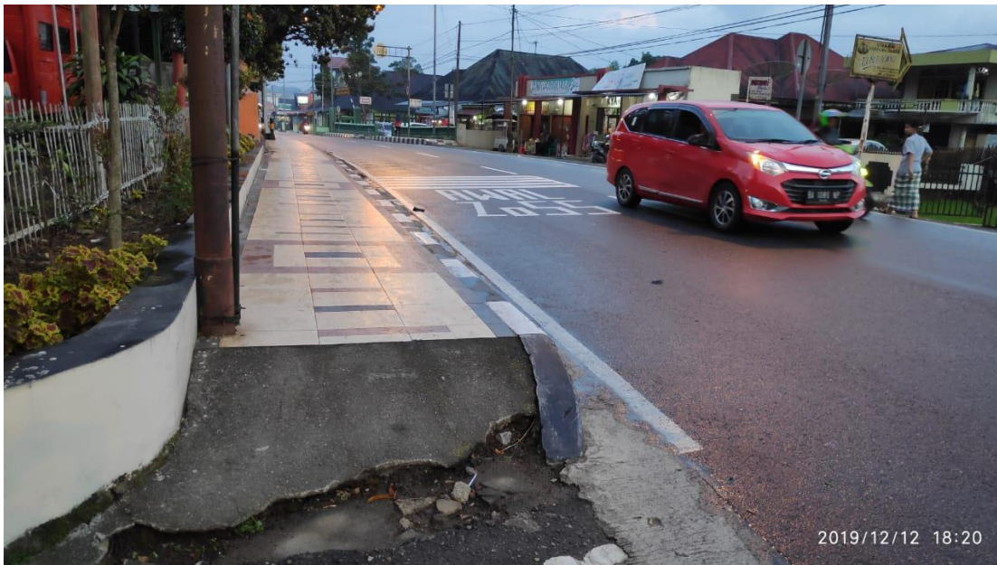
Gambar 4.24. Trotoar Lama Tanpa Ubin Pengarah
